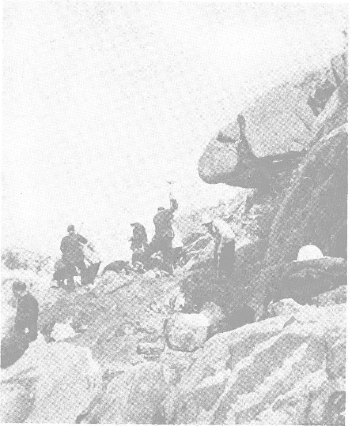
清理东山坡坝基
