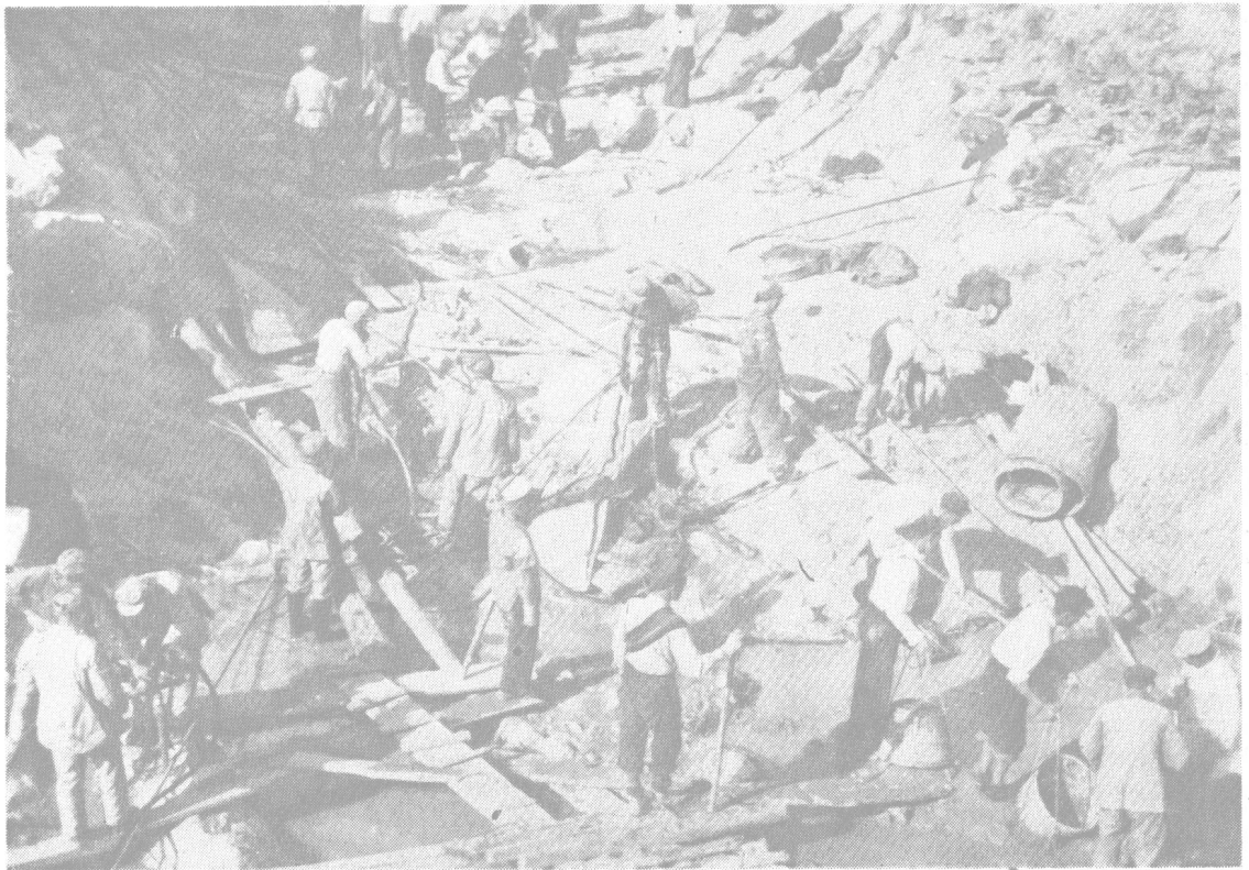
开挖坝墙基础石槽后，进行钻孔和水压试验，准备固结灌浆。
