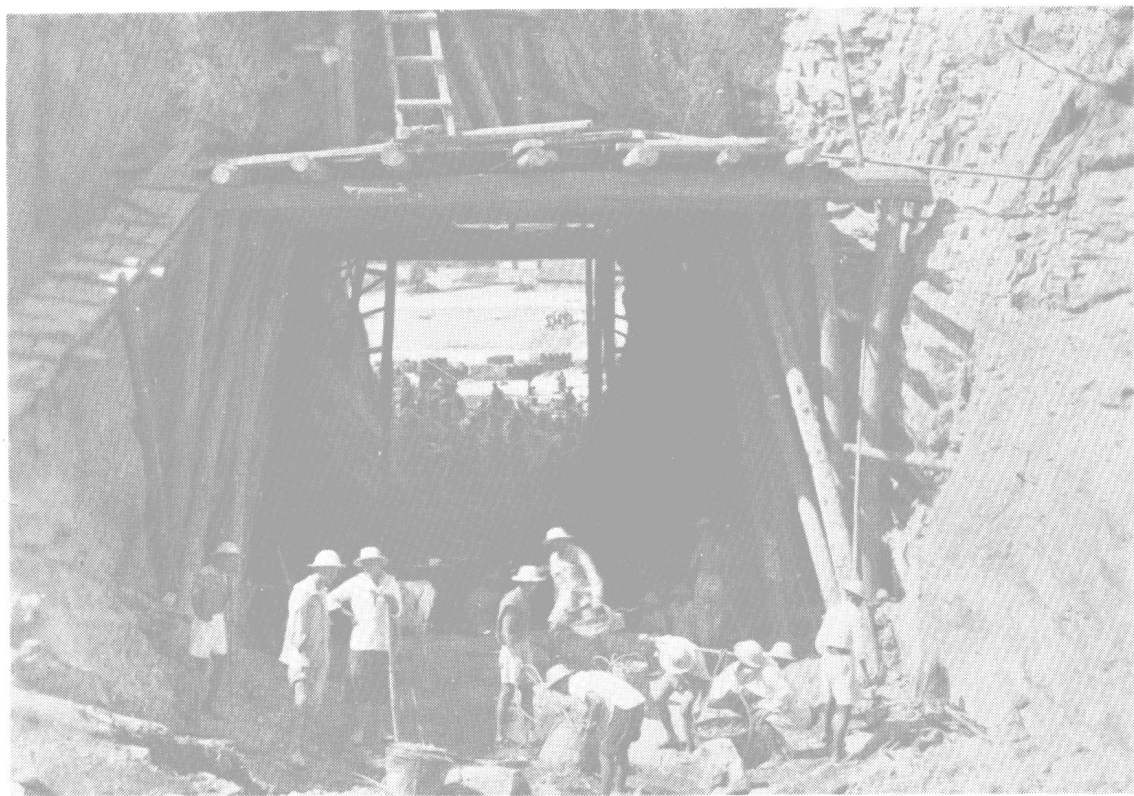
导流工程还有大梅山隧洞及桂冲明渠。图为大梅山隧洞。
