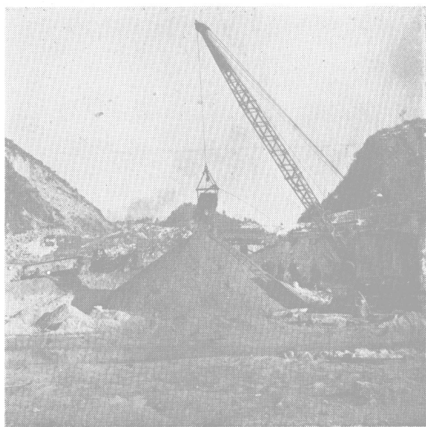
用吊車抓斗挖排水沟
