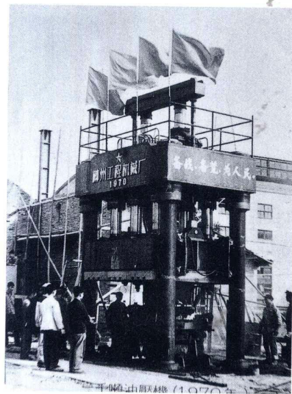
1970年9月，柳州工程机械厂研制成功广西最大压力设备—1000吨油压机。
