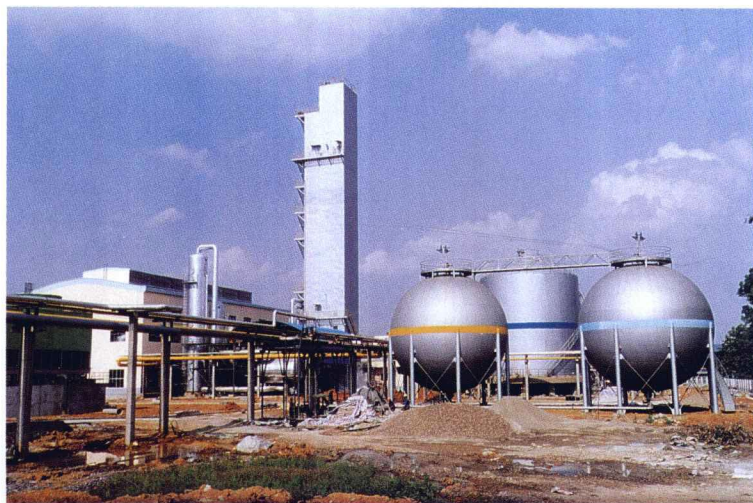
柳州钢铁(集团)公司“十五”重点技改工程 1.5 万立方米制氧机。
