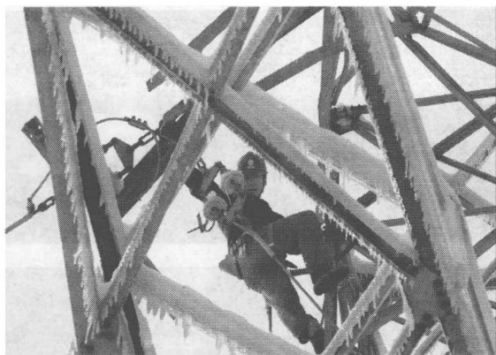
图 1-2 2008 年年初我国南方雪灾现场，巡检工人正在作业
