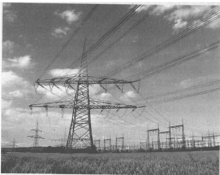
图 1-1 高压架空输电线路网络
