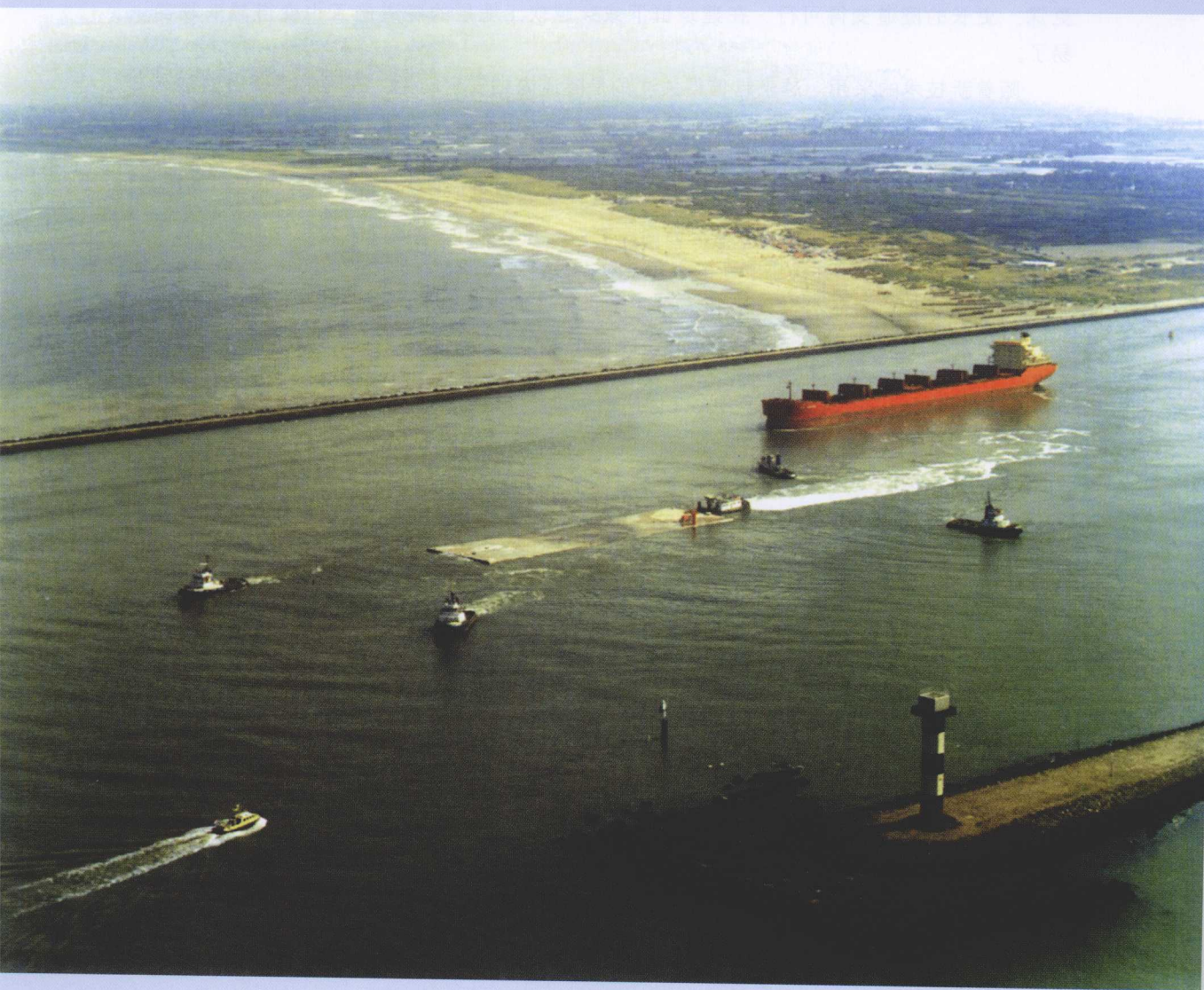
Caland隧道隧道单元的运输
