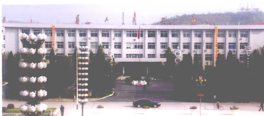
县委县政府办公楼
