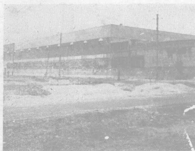
第六工場修復之後
