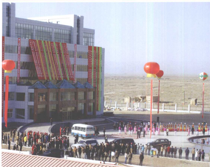
亚星矿业集团 200 万吨选矿项目竣工 投产
