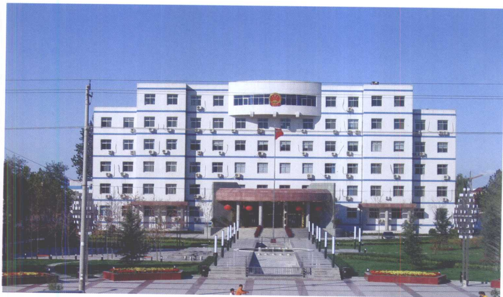
政府办公大楼
