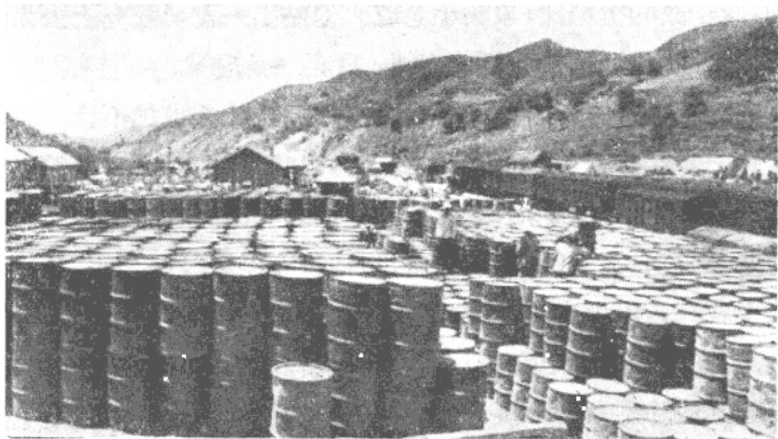
三国时代赵子龙鎮守的阳平关，現已成为貨物調运頻繁的車站。
