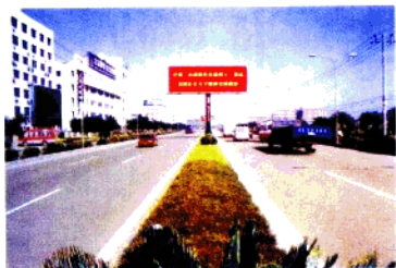
贯穿开发区的机场大道
