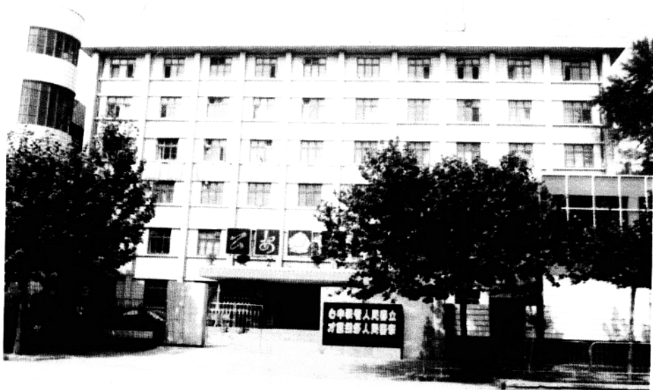
铜川市公安局 交警支队综合 大楼
