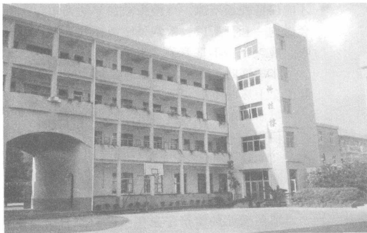
北仑柴桥小学兆庆科技楼。
