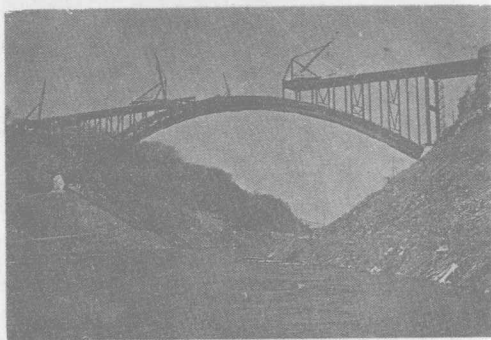
第 14 圖：這座橋由拱形架徑支持的橋面已經接近完成。它的 1000 呎長主架徑是這一類橋樑中最長的，它是由土木工程師所設計。
