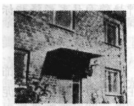
图24 维林格布居住 建筑石棉水泥遮板
