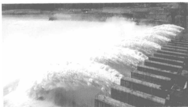
三峡水电站坝身孔口挑流消能(原型)
