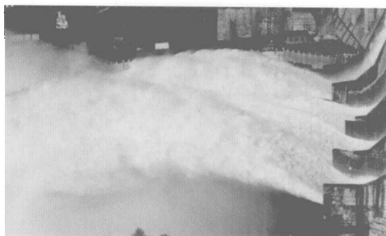
白山水电站溢流坝挑流消能(原型)
