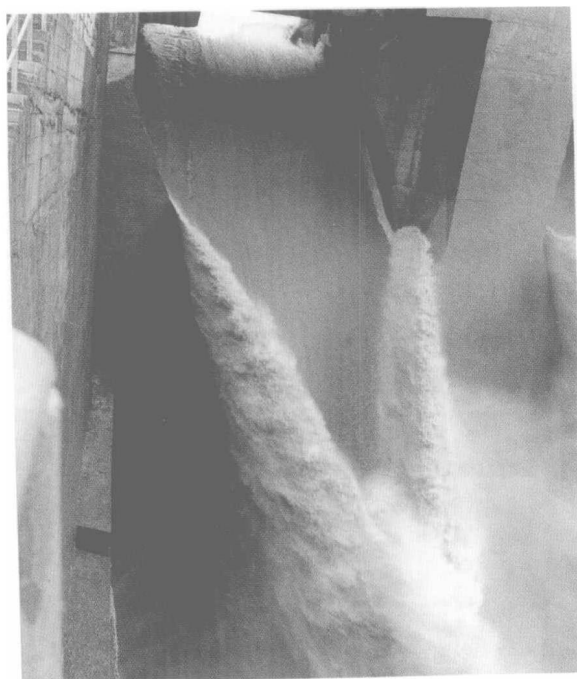
岩滩水电站宽尾墩戽式消力池消能
