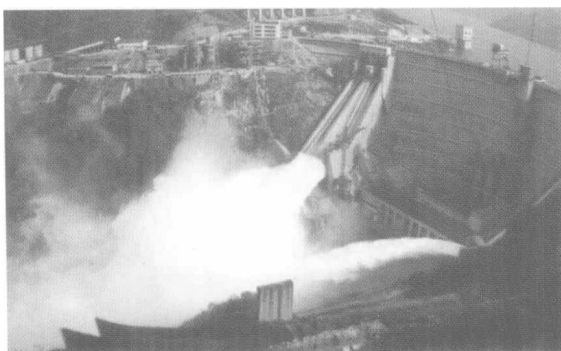
东江水电站溢洪道窄缝坎消能
