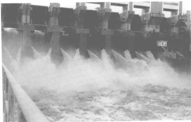
岩滩水电站宽尾墩戽式消力池消能
