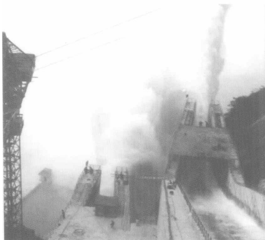
东江水电站溢洪道窄缝坎消能
