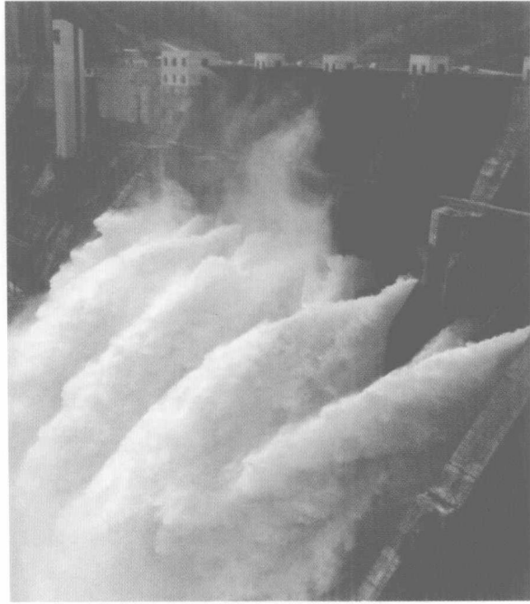
隔河岩水电站宽尾墩挑跌流水垫塘消能
