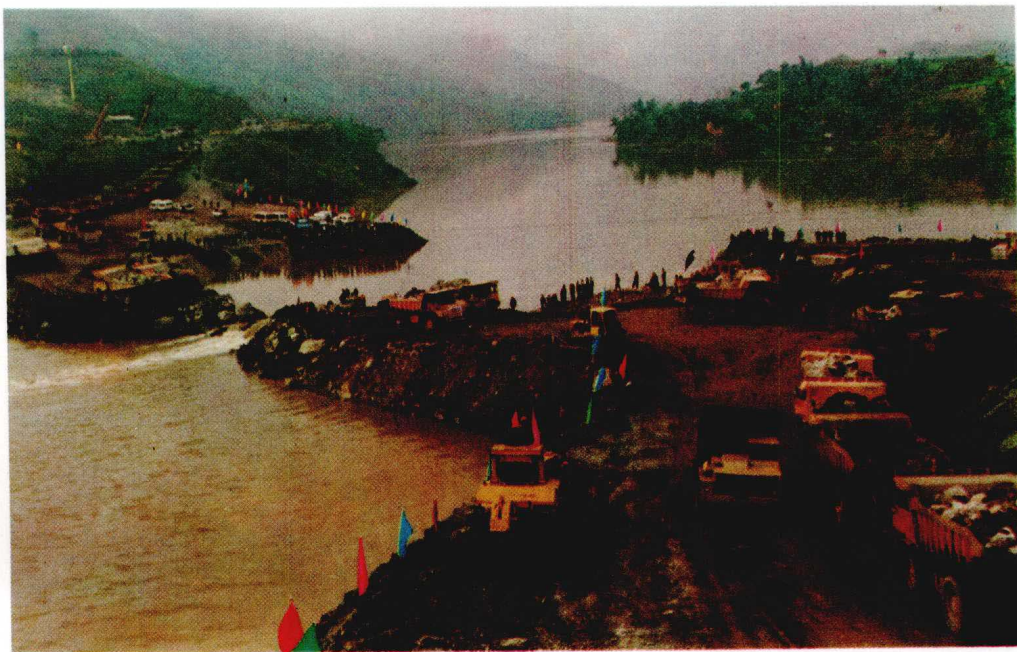
1994 年 12 月 25 日，天生桥一级电站大坝截流现场
