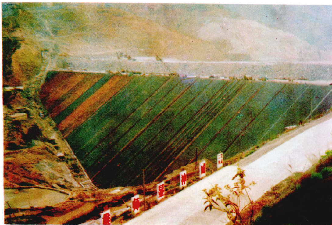
天生桥一级电站混凝土面板堆石坝，高 178m。
