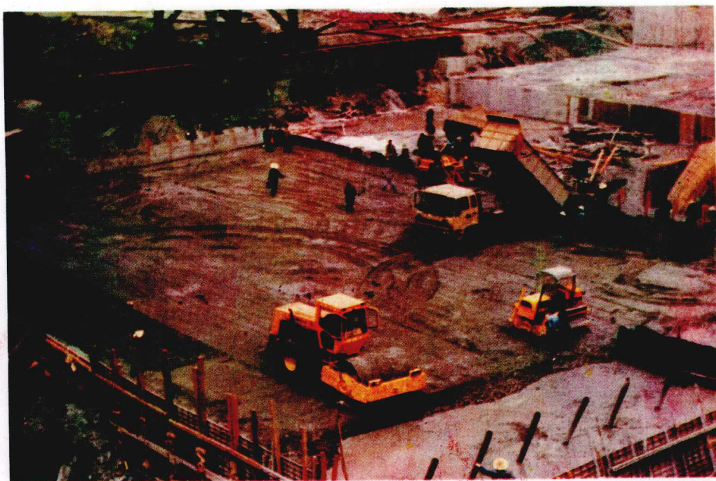
天生桥二级水电站大坝碾压混凝土施工现场
