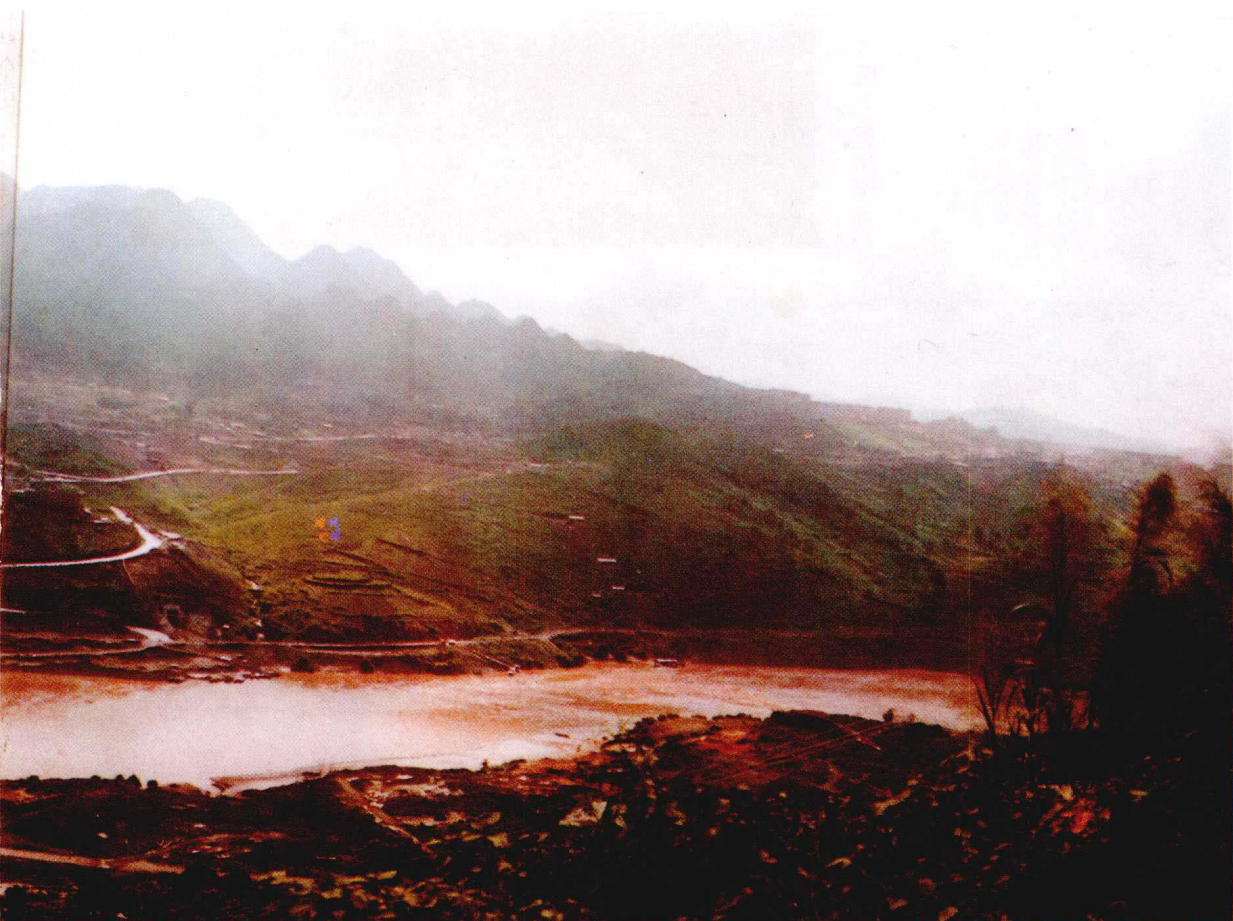
在建的天生桥一级水电站
