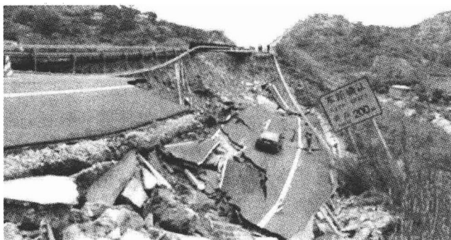
图 1.2 罗长高速公路垮塌图
