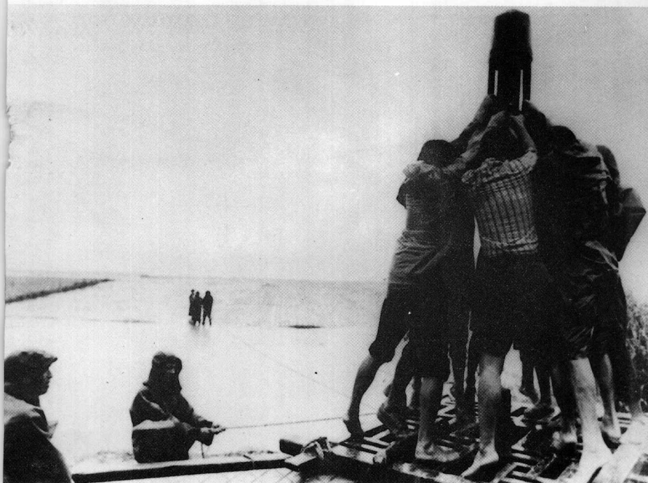
江苏暴雨成灾，全省人民齐心协力，奋力抗洪排涝。这是南京市江宁县周岗乡群众打桩护堤。
