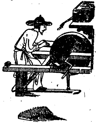
圖3 1668年中国的刀具磨床。
