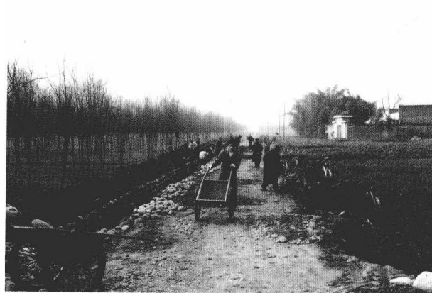
图4 火热的施工现场
