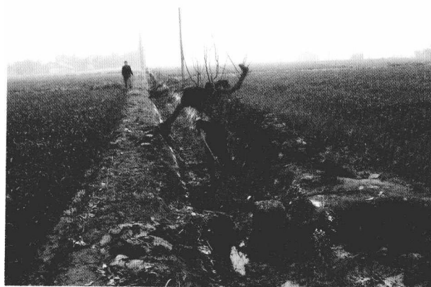
图3 农渠清理淤泥, 施工人员现场测量
