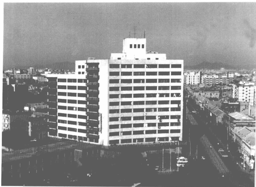
大连海运(集团)公司办公楼(民主广场1号)
