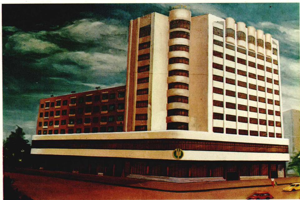
建设中的中国农业银行毕节地区中心支行办公大楼图型。
