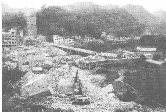
图2 湖南省凤凰县“08.13”大桥坍塌事故现场（二）
