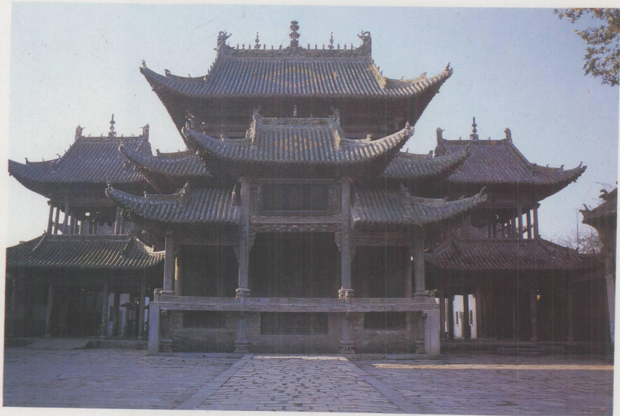
社旗县山陕会馆悬鉴楼
