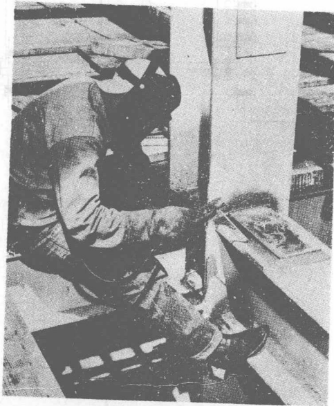
一半剛性梁 - 柱結合的施工照片，佛羅里達州，邁阿密城的恩斯雪大樓
