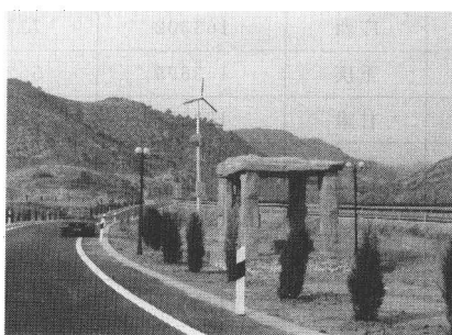
图 1.8 风力发电系统为山西德大高速公路的信息系统供电
