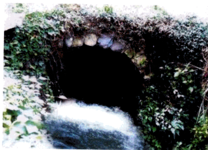
古石拱桥(洞桥)
