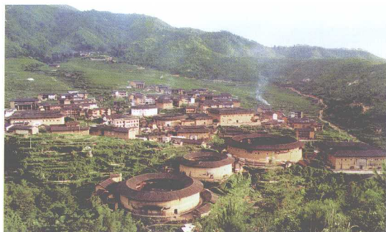
2008年7月，福建土楼被列入《世界遗产名录》。图为福建土楼俯视图。
