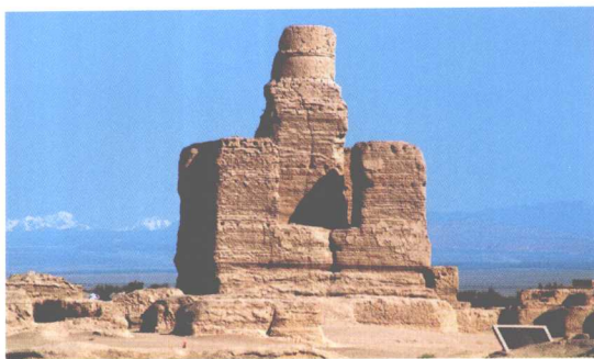
2006年8月，“丝绸之路（新疆段）重点文物抢救保护工程计划”正式启动，其中交河故城抢险加固工程（第一期）投入维修资金4000多万元，图为维修前的交河故城。
