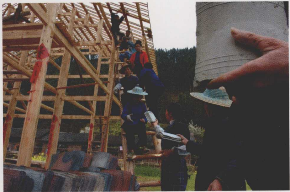
修建干栏式建筑
