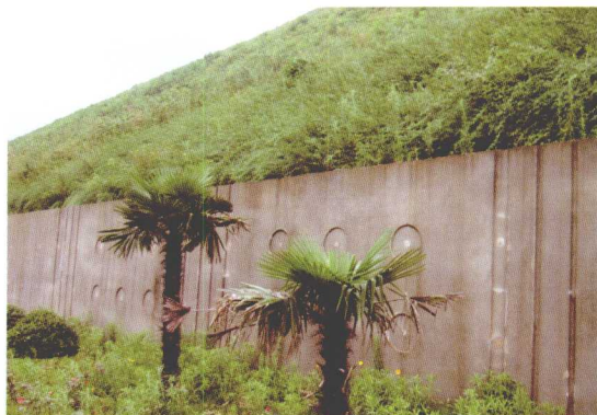
图 4-5 挖方地段碎落台绿化示例
