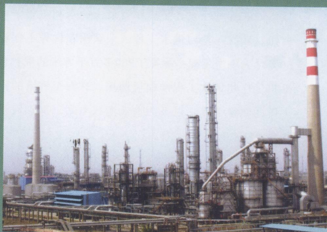
洛阳石化化纤工程
