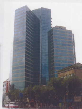
上海东方国际广场幕墙工程（鲁班奖）
