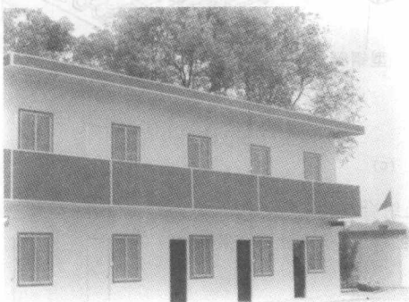
图 1.16 钢结构临时用房
