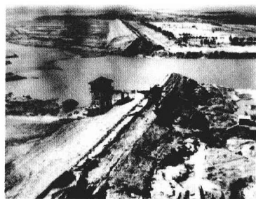
板桥水库大坝被洪水 冲垮后的惨状
