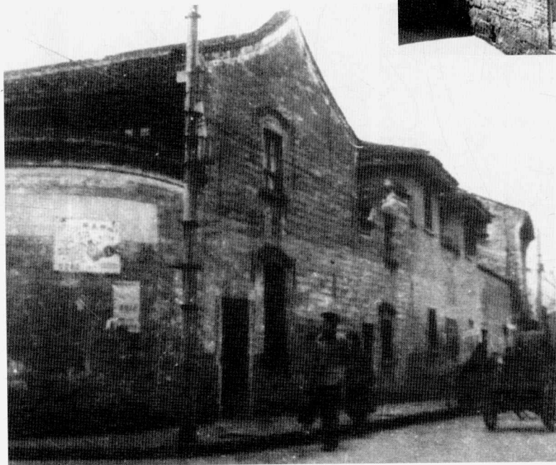
宁波大河路64号中共鄞县县委、宁波中心县委旧址。
