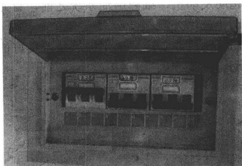
图 1-18 供电开关的过流保护和接地保护
