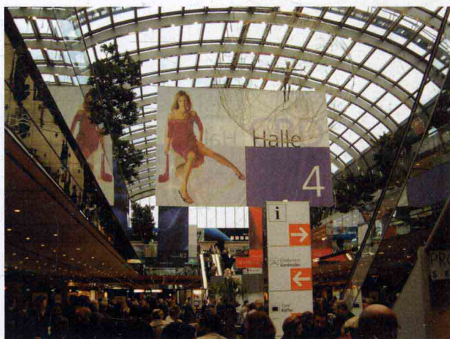
图 2-10-B 德国杜塞尔多夫展览中心大厅，屋顶为拱形天窗，是自然采光良好的共享空间。
