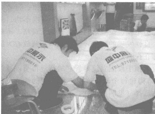
图 1-9 国内展示工程施工现场
