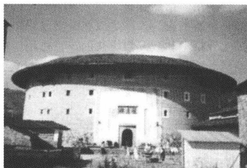
图0-1-3 福建怀南靖县1909年用河卵石和三合土建造的怀远楼
