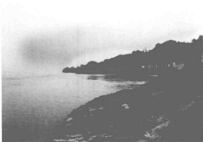
下峪口黄河堤防工程
