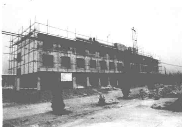
正在建设中的龙门供水工程
