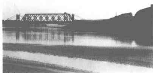
禹门黄河铁路公路桥
