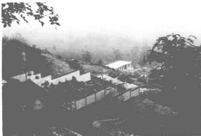
大池埧供水工程
