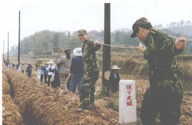
1998年初，梧州军分区组织13万部队战士、民兵参加柳州至梧州、贵港至梧州280多公里的光缆施工
