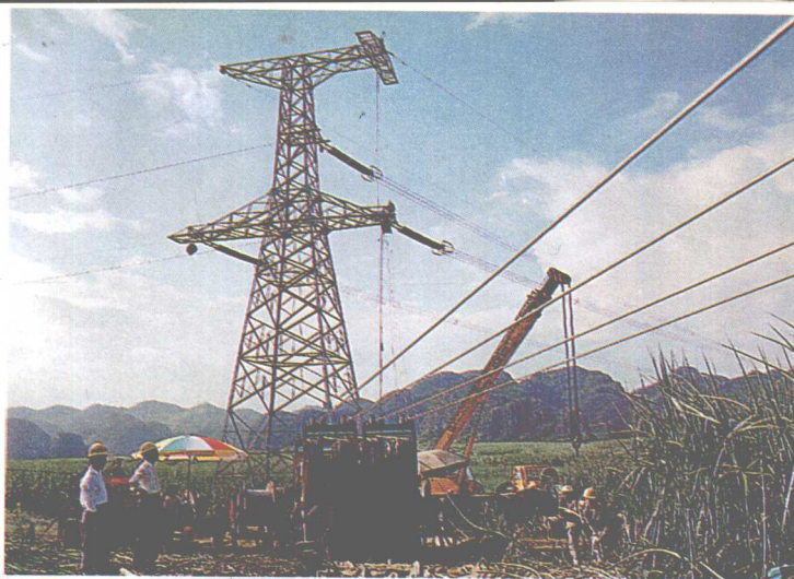
► 500kV 输电线路张力架线施工现场。
