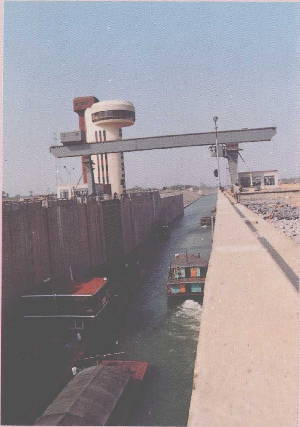
图 40 船舶通过桂平枢纽船闸
