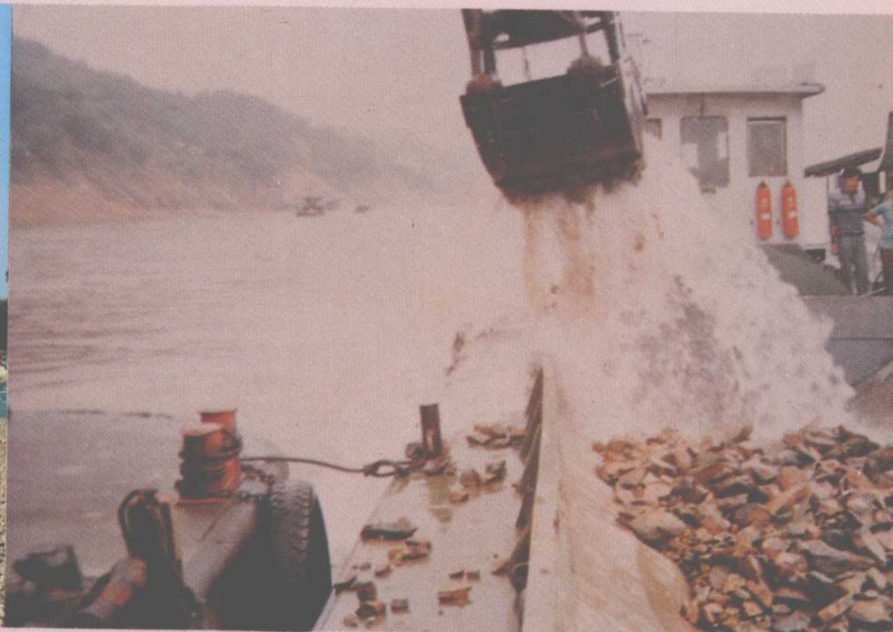
图 44 西江鸡笼洲疏浚
