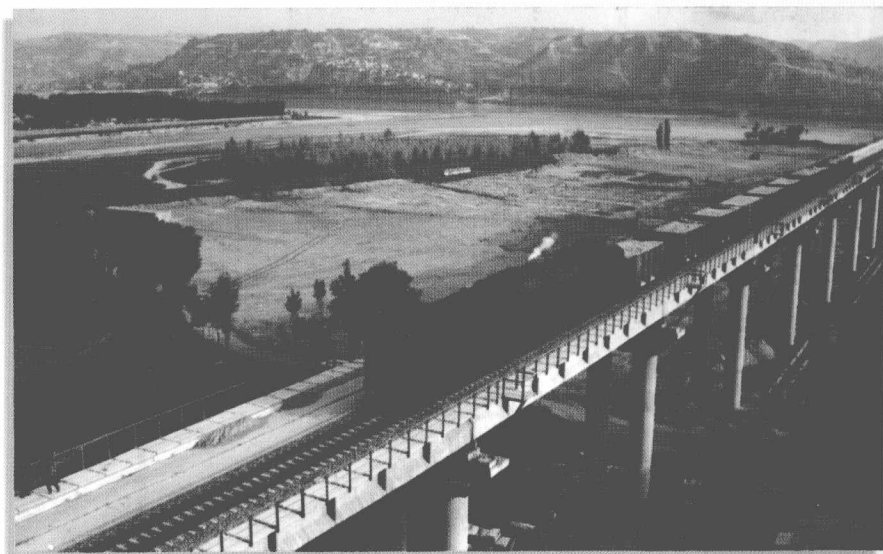
府(谷)保(德)黄河铁路大桥
