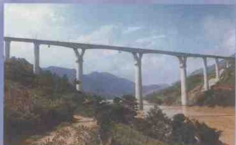
亚洲第一、首次采用V型支撑的 南昆线南盘江大桥
