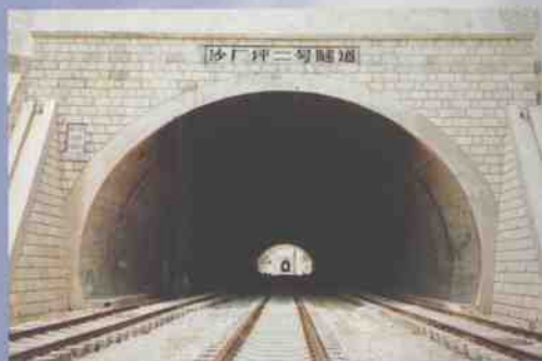
南昆线唯一的三线隧道——沙厂坪隧道
