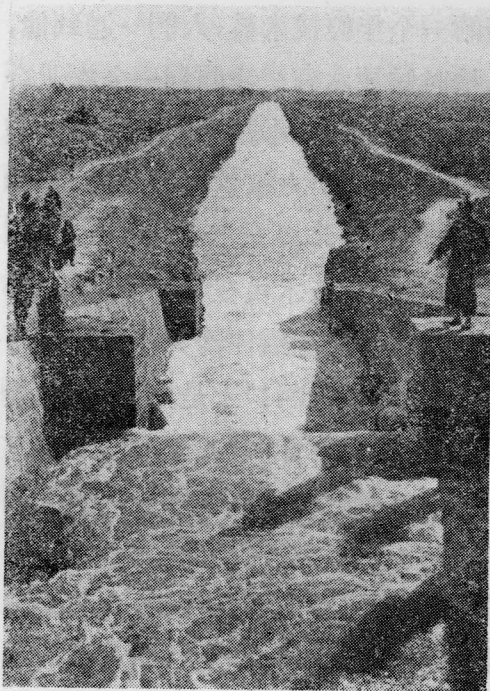
白沙灌溉渠渠道
