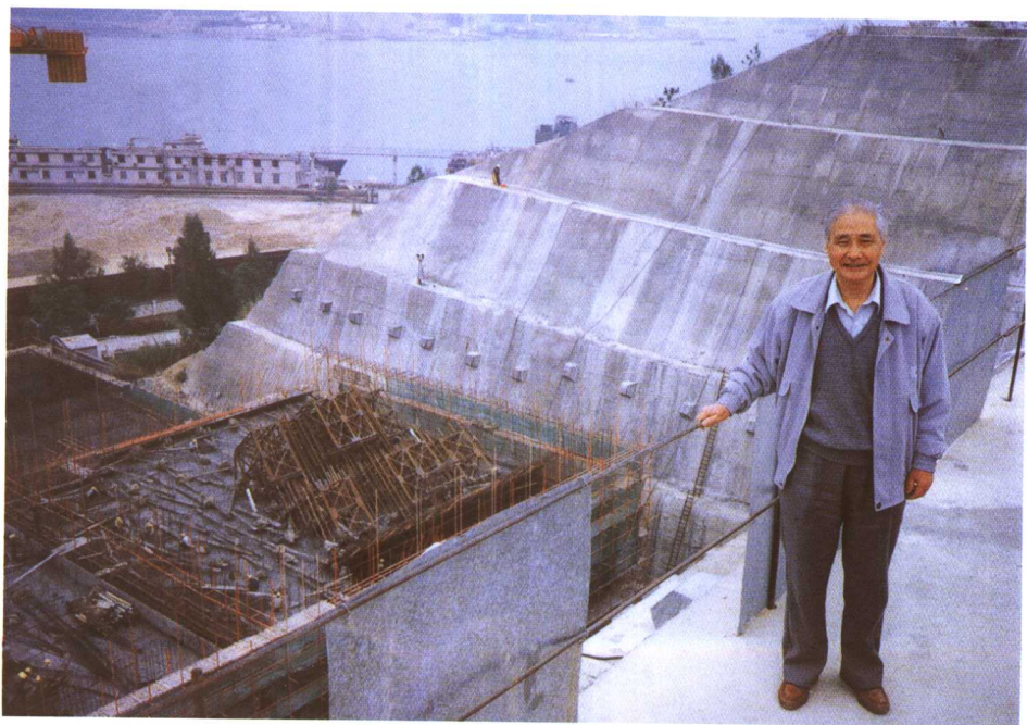
在厦门海沧大 桥东锚墩工地
