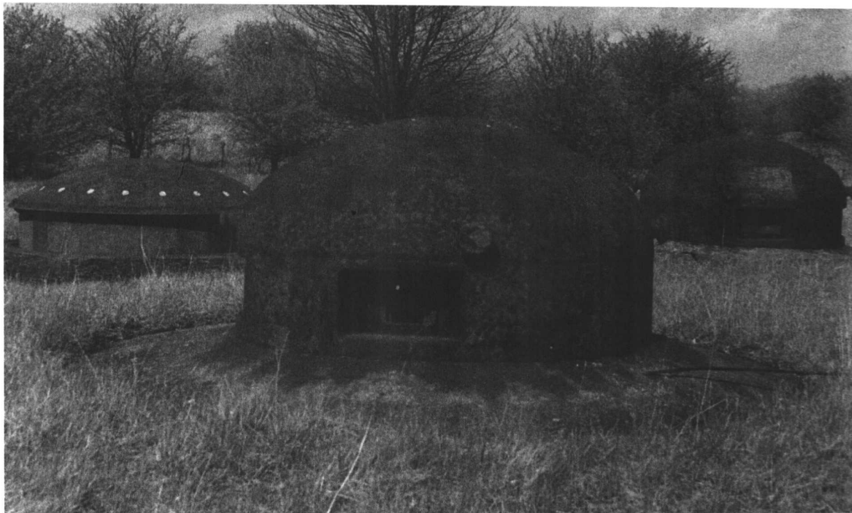
■ 罗匈维尔大型工事群3号战斗区域。地上右边是两个有装甲防护的观测和自动步枪钢罩，用于工事群表面的近距离防御。左边是升起后的区域炮兵炮塔，装备了两门75毫米M1932-R榴弹炮
