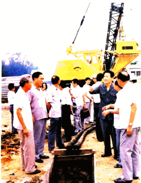
► 北京市常务副市长张百发等领导同志视察北京城建机械公司引进的大直径钻孔机
