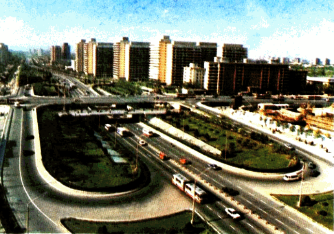
▲ 北京城建机械施工公司承建的建国门三层立交桥
