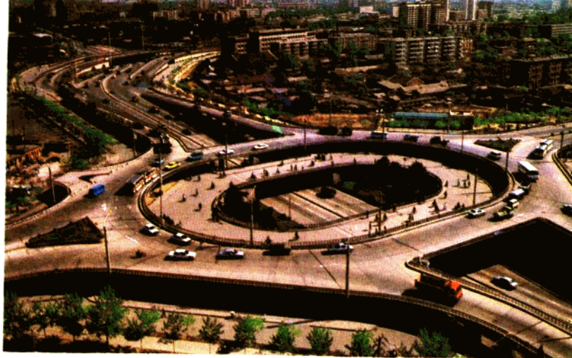
▲ 北京第一城建公司承建的我国第一座三层转盘式西直门立交桥
