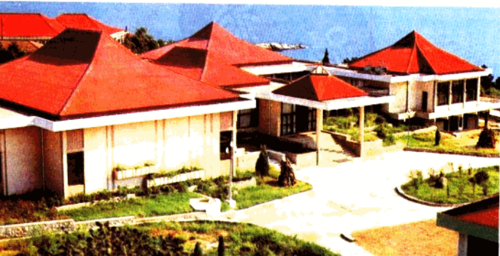
▼ 北京市第四城建工程公司承建的国务院北戴河会议楼
