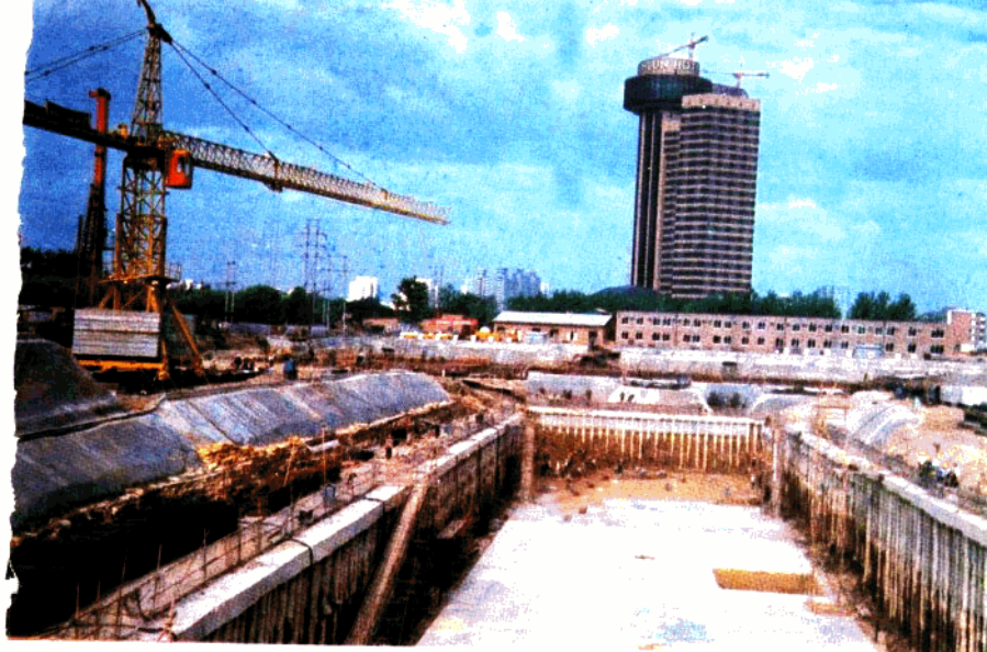
▲ 西德汉莎航空公司投资的北京康华地下工程公司承建的北京燕莎中主楼正在建设中
