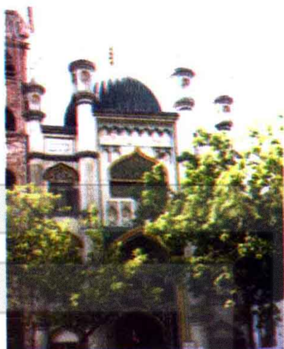
△乌鲁木齐市山西巷清真寺及正在修建的附属建筑。
