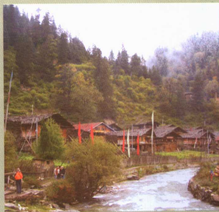
▲ 四川 柴盖村 卡龙沟流出的雪水
